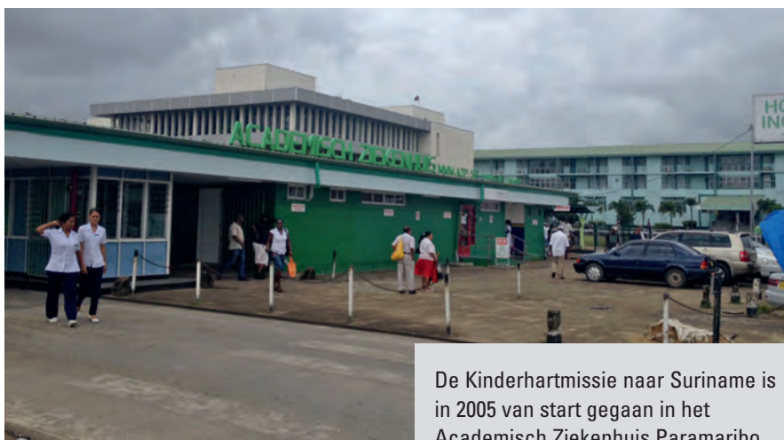
Foto 1. Het Academisch Ziekenhuis Paramaribo.
